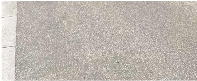
Enrobé grenailé (sur la chaussée dans le centre-bourg)
