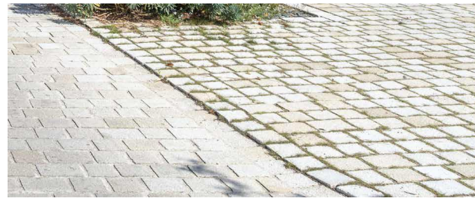
Pavés à joints enherbés (sur les trottoirs du centre-bourg)
