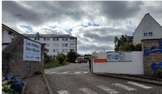
Vue sur l'ancien lycée (parcelle 53), depuis le giratoire, au Sud-Est du site de projet
