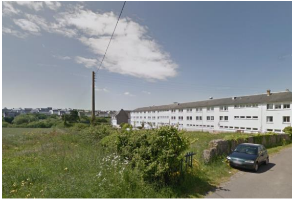
1 – Vue vers le lycée depuis la Rue des Bruyères
