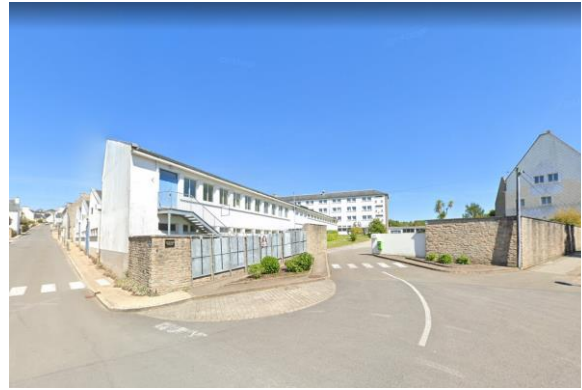
2 – Vue du lycée depuis le rond-point Rue de la République
