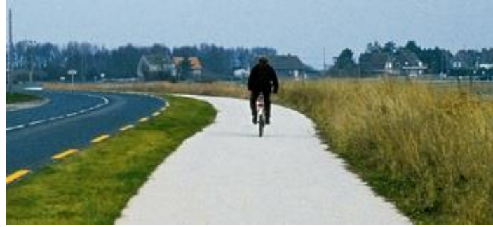
Enrobé coloré (sur la voie verte et les trottoirs hors centre-bourg)
