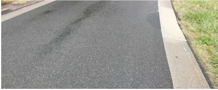
Enrobé noir et bande de résine en rives (en dehors du centre-bourg)
