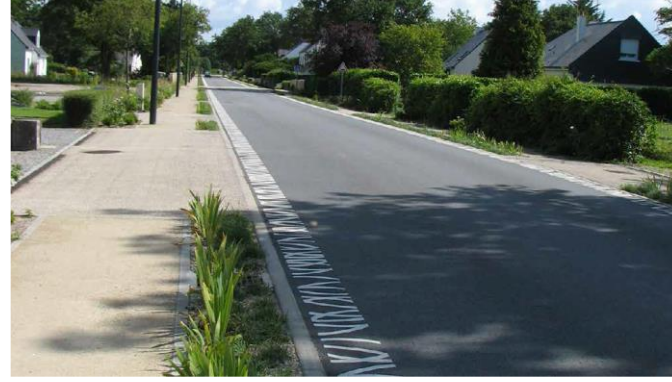
Marquage au sol en rive de chaussée et platebande plantée
