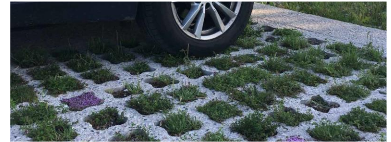
Béton alvéolé enherbé (pour les places de parking dans le centre-bourg)
