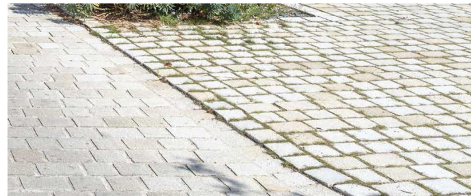
Pavés à joints enherbés (sur les trottoirs du centre-bourg)
